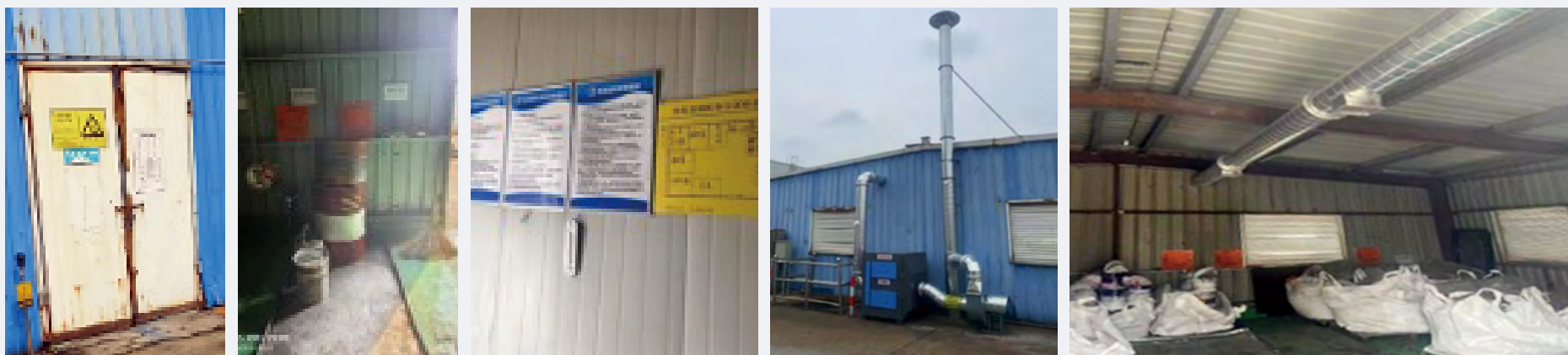
川源（中國）廠區張貼警語、說明告示及新增有機廢氣處理設備 - 活性炭吸附裝置
